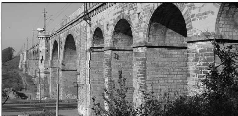
Rys. 4. Przęsła mostu nad dawną Młynówką, obecnie droga krajowa
