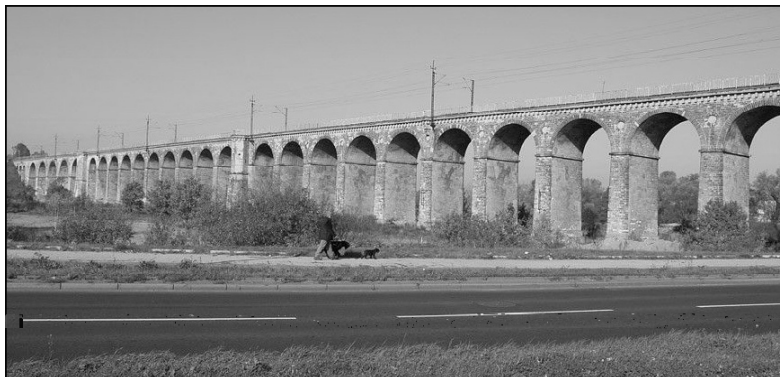
Rys. 5. Przęsła mostu nad terenem zalewowym - sekcje środkowe
